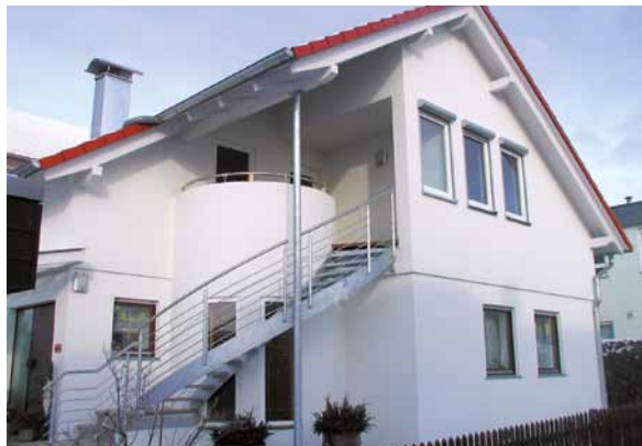
Über eine Außentreppe lassen sich eigene Eingänge für die getrennten Wohnbereiche realisieren.
