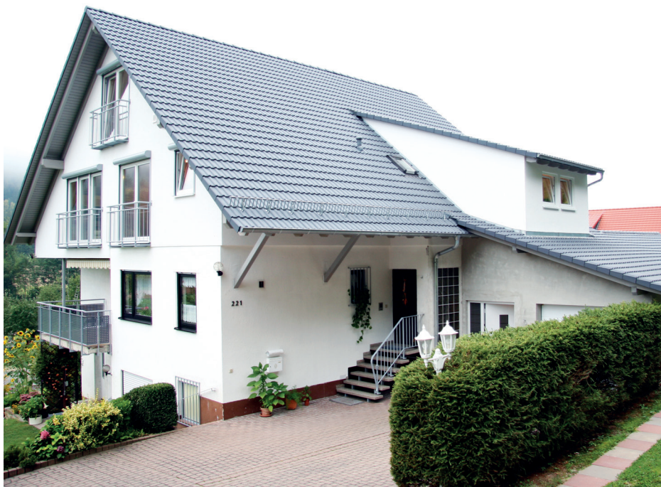
Ein Dachausbau schafft mehr Platz zum Leben und mehr Flexibilität in der Lebensgestaltung. (Foto: epr/DachKomplett/FGZH mbH) 033 02
