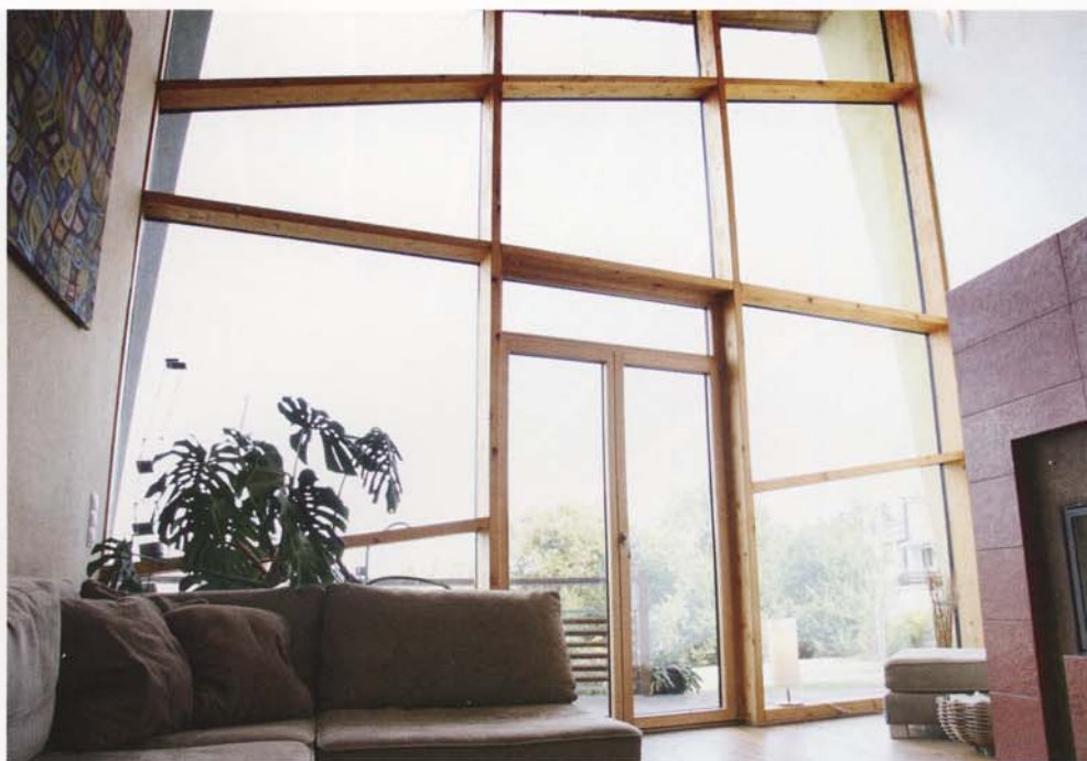
Die großzügige Verglasung in asymmetrischer Pfosten-Riegel-Konstruktion lässt viel Licht in den Wohnbereich.
