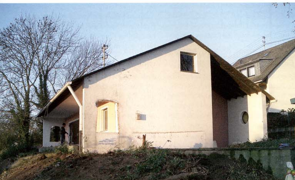
Den Bestand ließen die Bauherren bis auf den Keller komplett abreißen.
