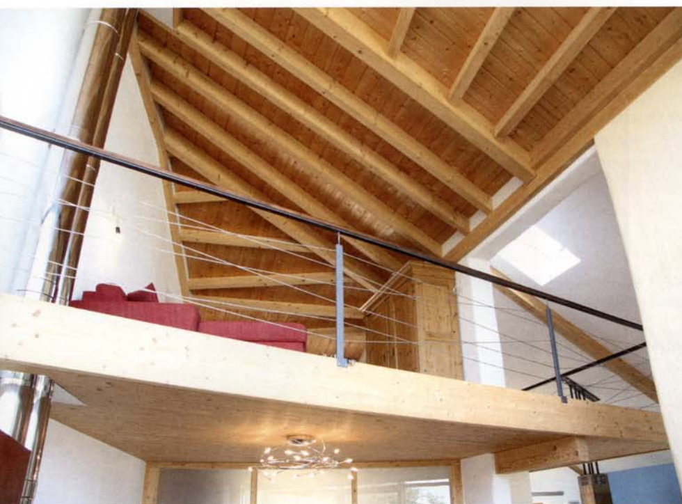
Über allem schwebt die in Holzbauweise erstellte Galerie.
