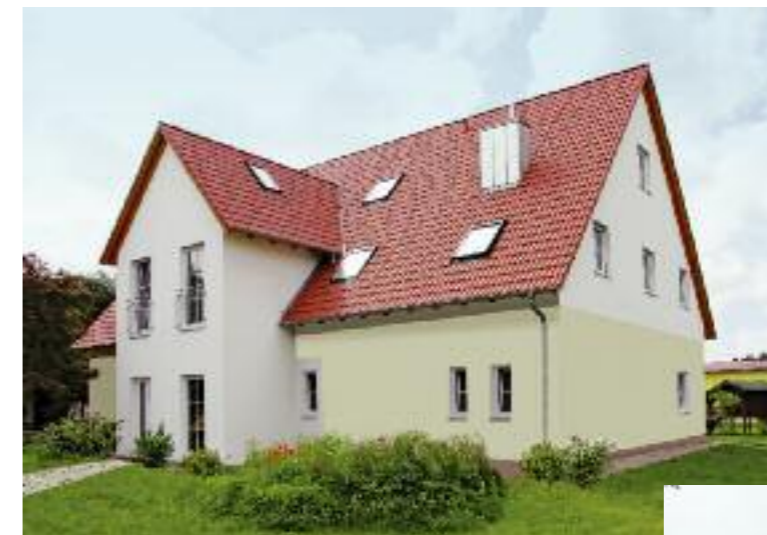
Bei diesem Beispiel entstand ein Mehrgenerationenhaus mit Mietwohnung und Büro. Die ursprüngliche Wohnung der Eltern mit Büro an der angrenzenden Gärtnerei (Bild unten) wurde in Fertigbauweise für die Kinder aufgestockt.
