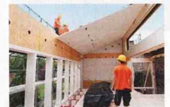
Schließlich wurden die großformatigen Dachelemente eingepasst.
