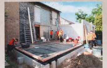
Auf das abgedichtete Betonfundament wurden Schwellen montiert.
