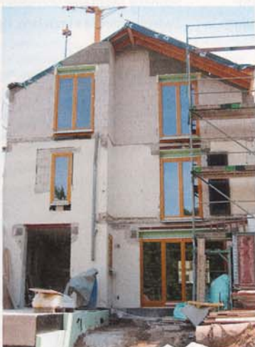
Die ursprünglich breite Traufseite des Hauses wurde durch den umfassenden Umbau zur Giebelseite.
