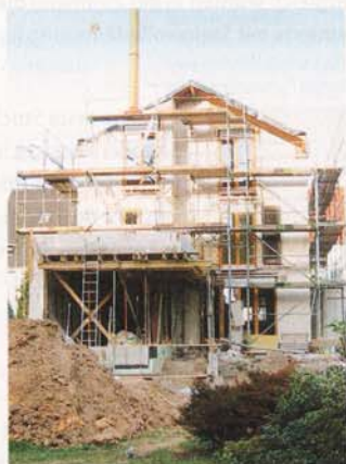
Hinten bekam das Haus noch in den Garten einen Anbau.a
