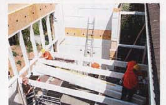
Erst dann hat man die Balkenlage der Zwischendecke eingezogen.
