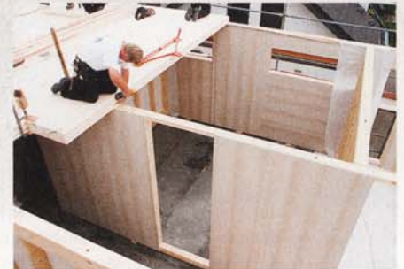
Schnelle Montage: Wandelemente aufstellen, Zwischendecke einziehen, dann noch das Dach.
