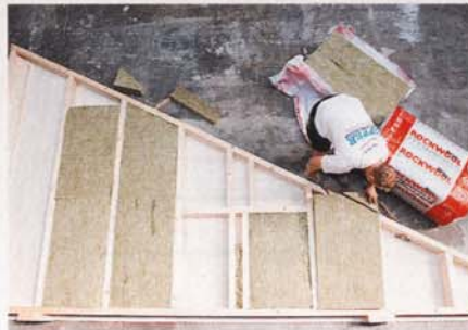
Zeitgleich wurden in der Zimmerei die Wandelemente mit Steinwolldämmung konstruiert.
