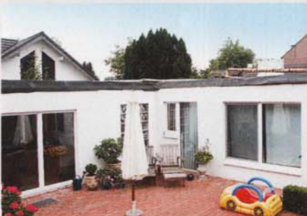
Das Walmdach wurde demontiert und die Erdgeschossdecke mit einer Schüttung geebnet.
