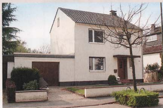
Die ursprünglich breite Traufseite des Hauses wurde durch den umfassenden Umbau zur Giebelseite.
