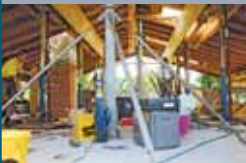
Gut abgestützt und gesichert präsentiert sich das Dach auch von innen.
