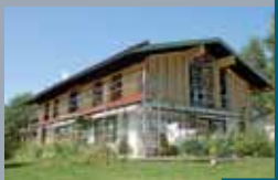
Während der gesamten Bauphase konnte das Ehepaar Hollender-Beucke im Haus wohnen.
