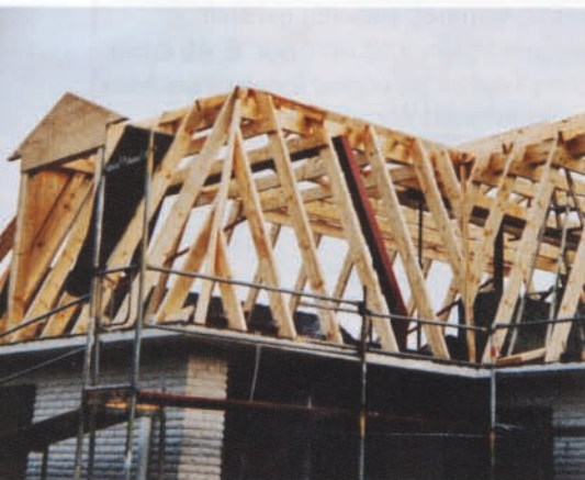
Das alte Walmdach wurde abgerissen und durch ein schickes Mansarddach mit mehreren Gauben ersetzt.
