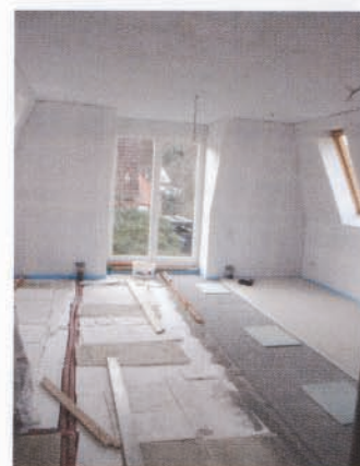
Durch die Dachaufstockung entstand ein zusätzliches Stockwerk mit 100 m 2 Wohnfläche
